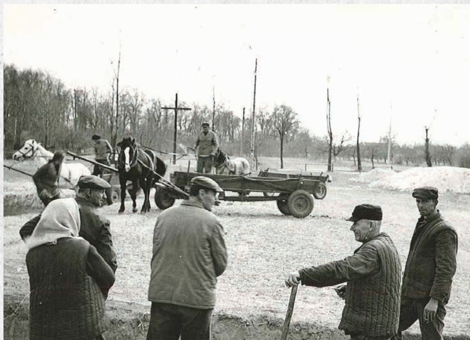
Prace przy kopaniu fundamentów (rok 1974)
