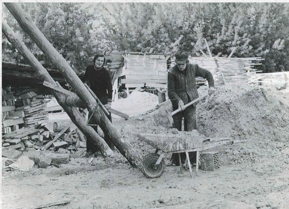
Prace na placu budowy kościoła w Orońsku (rok 1974)
