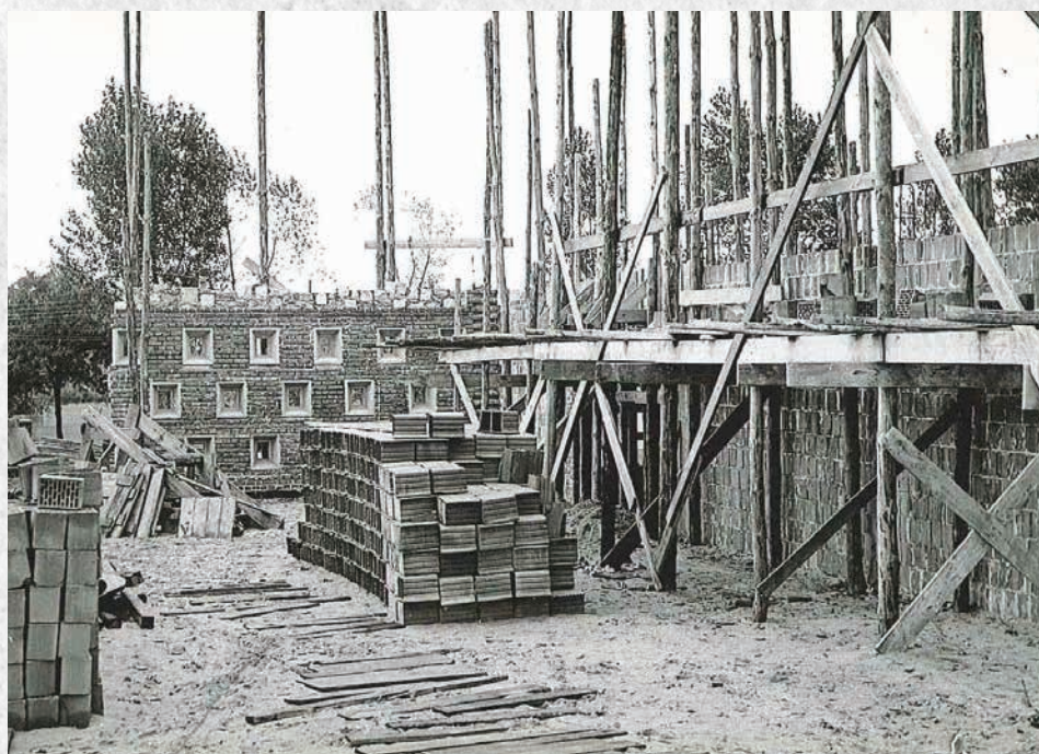
Budowa kościoła parafialnego w Orońsku (lata 1974–1978)
