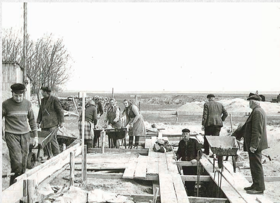
Prace związane z wykonaniem fundamentów (rok 1974)
