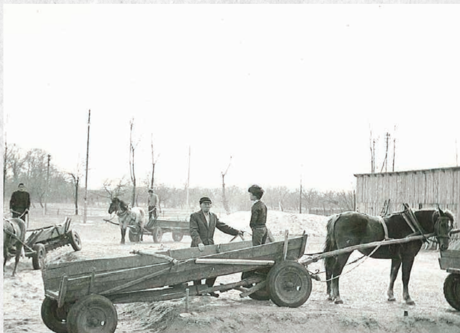
Prace przy kopaniu fundamentów (rok 1974)
