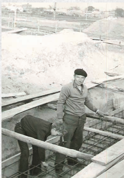
Prace przy zbrojeniu fundamentów (rok 1974)
