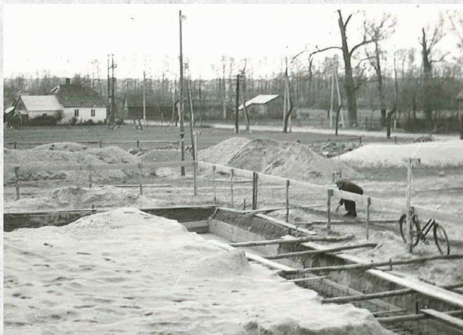
Wykopy pod fundamenty nowego kościoła w docelowym miejscu (rok 1974)
