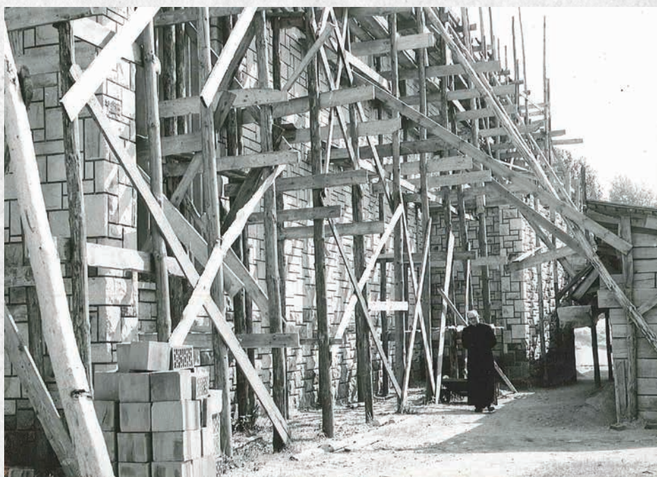
Budowa kościoła parafialnego w Orońsku (lata 1974–1978)
