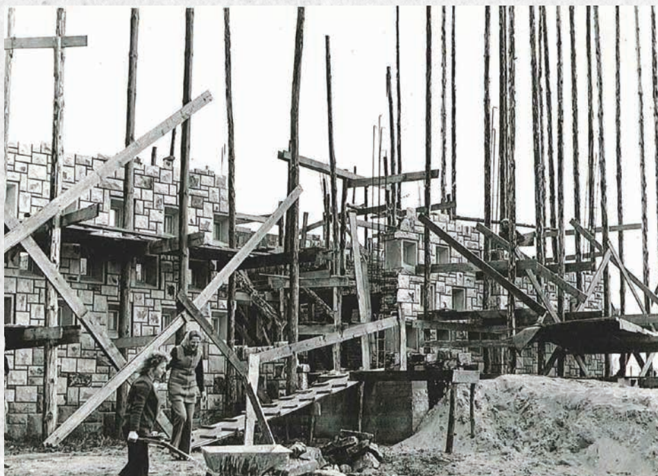
Budowa kościoła parafialnego w Orońsku (lata 1974–1978)
