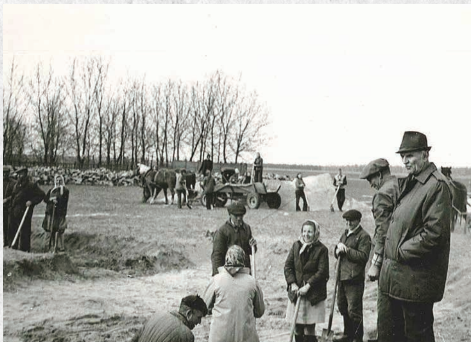
Parafianie przy kopaniu fundamentów (rok 1974)
