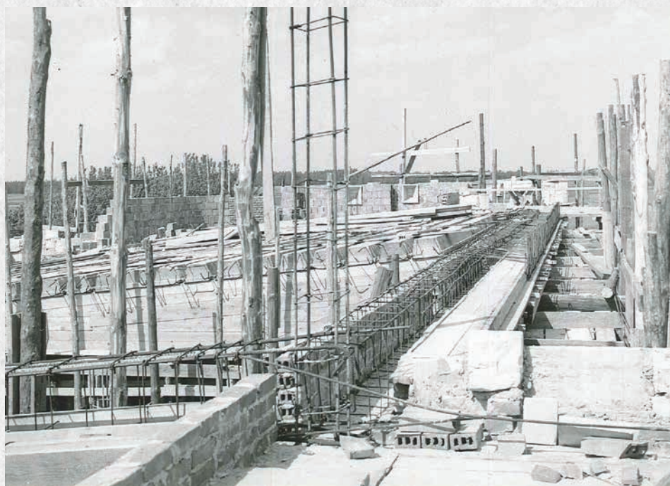
Budowa kościoła parafialnego w Orońsku (lata 1974–1978)
